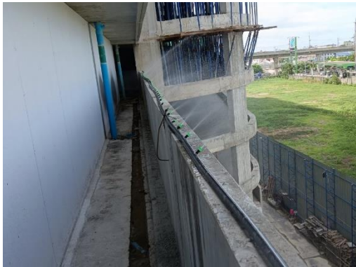
รูปที่ 9 ติดตั้งสเปรย์น้ำบนอาคาร
