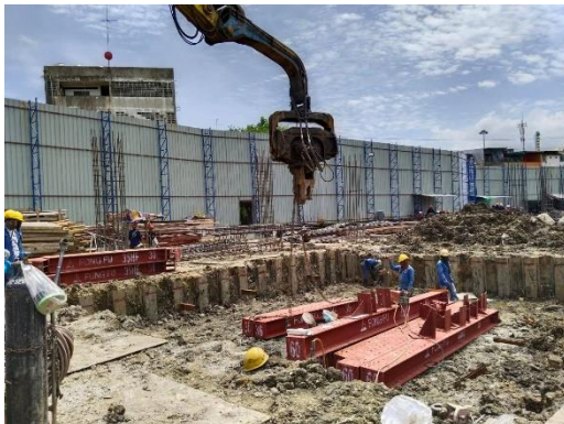
รูปที่ 5 ติดตั้ง Sheet Pile
