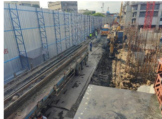
รูปที่ 5 ติดตั้ง Sheet Pile
