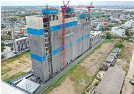
รูปที่ 11 ติดตั้งผ้าใบก่อสร้าง (Mesh sheet) ตลอดความสูงอาคาร
